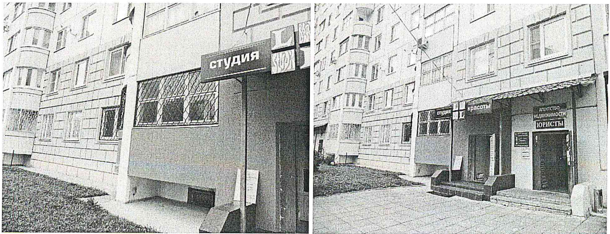
со стороны проезжей части , на первом этаже при входе в нежилое помещение со стороны 4-го подъезда фасад окрашен в яркий цвет
